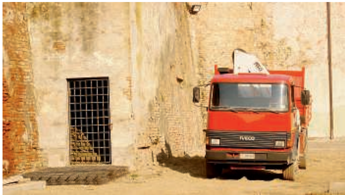
La zona ripulita: il lavatoio è sparito dal cantiere di piazza d'Armi
